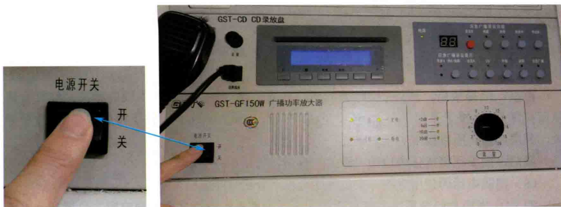
图6-27 打开广播功率放大器的电源开关
