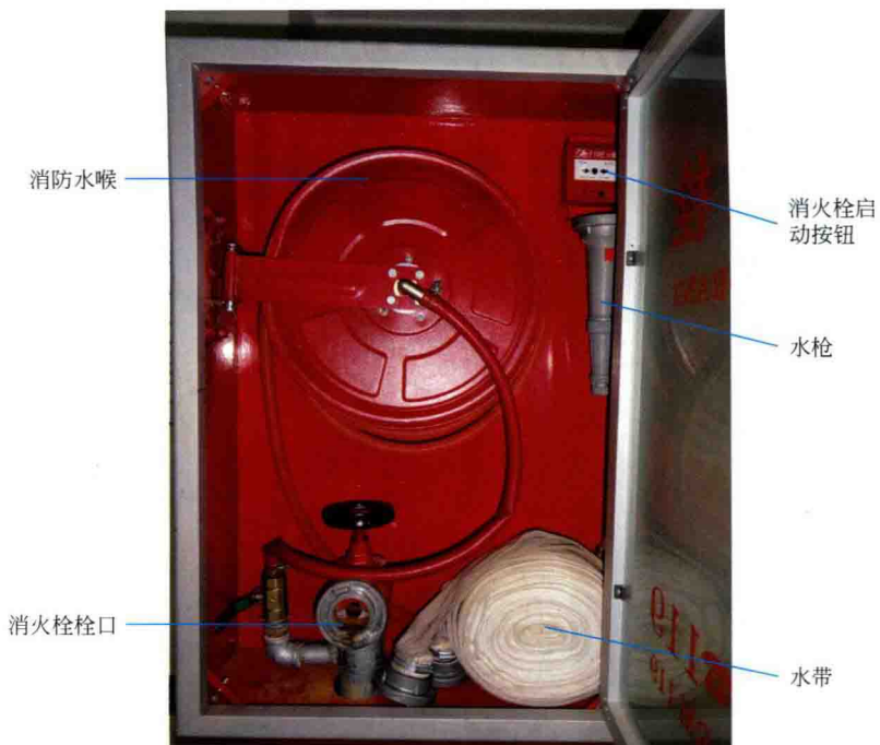
图5-24 室内消火栓各组成部分示意图
