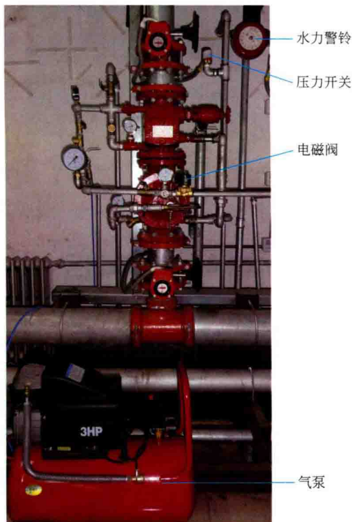
图5-12 预作用自动喷水灭火系统
