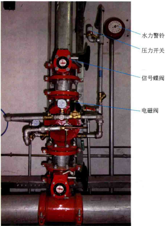
图5-10 雨淋自动喷水灭火系统
