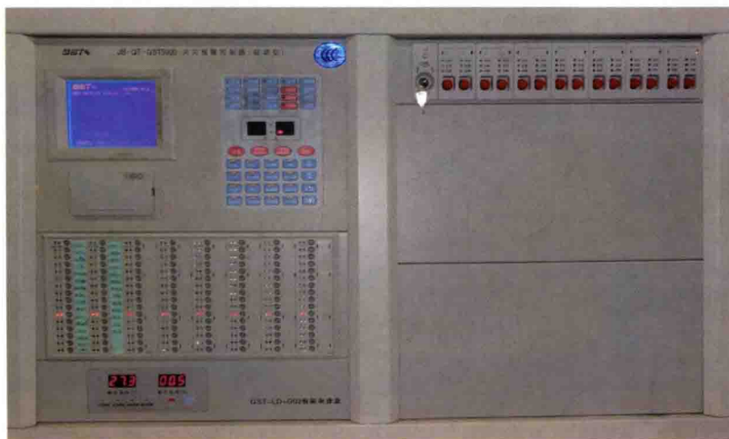
图 6-2 火灾报警控制器（联动型）
