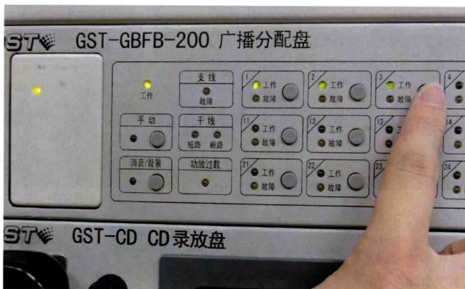
图6-30 刷卡解锁，并按下着火层及相邻层
