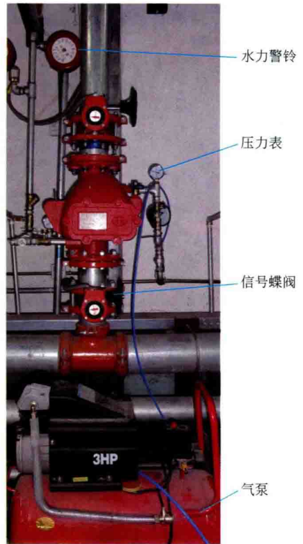
图5-11 干式自动喷水灭火系统
