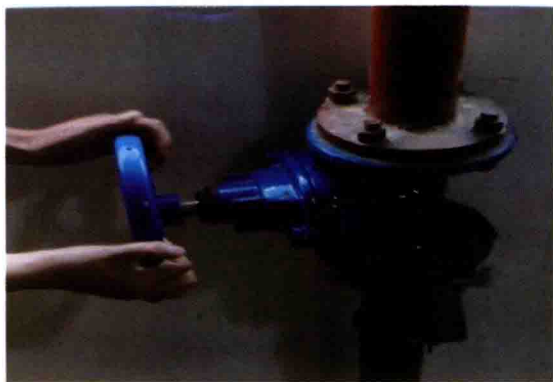
图10-14 打开水炮入口阀门
