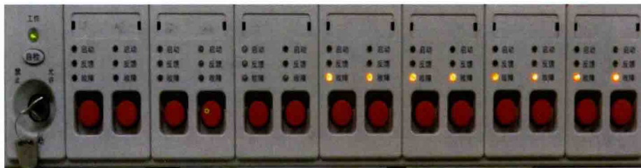
图9-60 多线制控制盘
