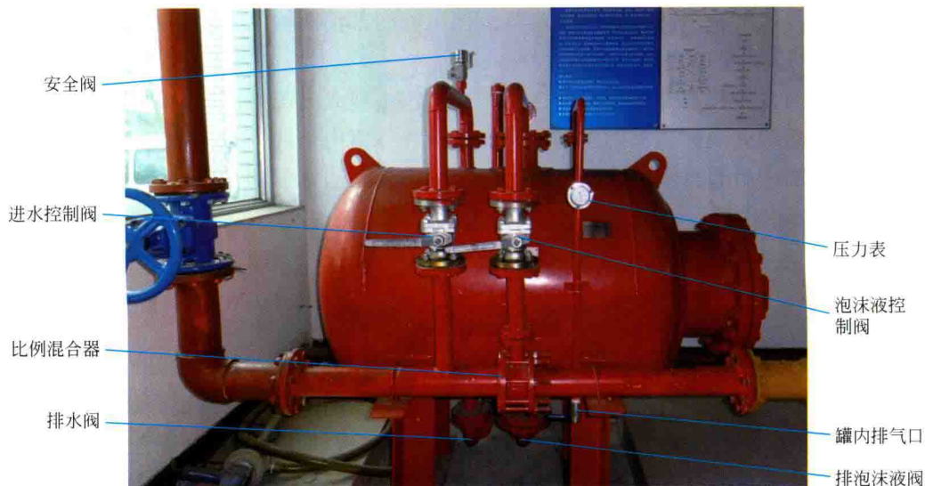
图 10-42 泡沫比例混合装置
