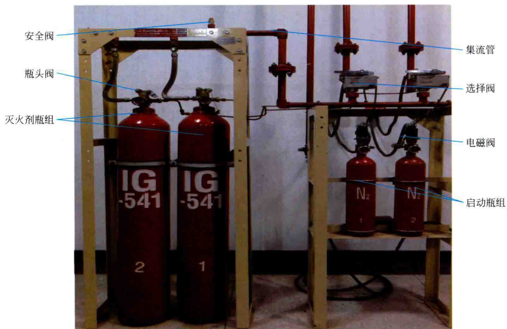
图 10-47 IG-541 储气瓶式灭火系统
