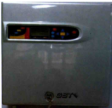
图 9-94 空气采样感烟探测器
