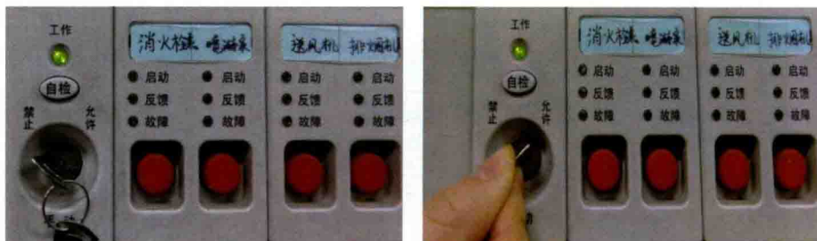
图9-61 将多线制控制盘由禁止状态切换到允许状态
