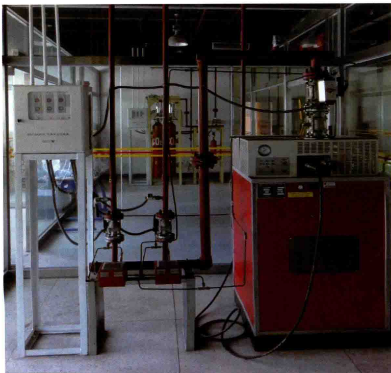
图 10-46 低压二氧化碳灭火系统
