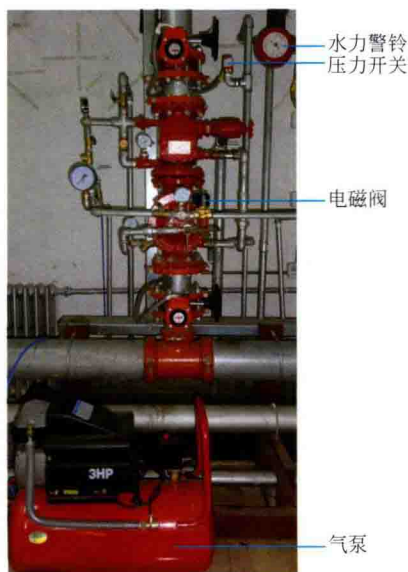
图 10-20 预作用自动喷水灭火系统
