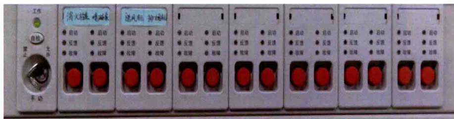
图 9-67 多线制控制盘
