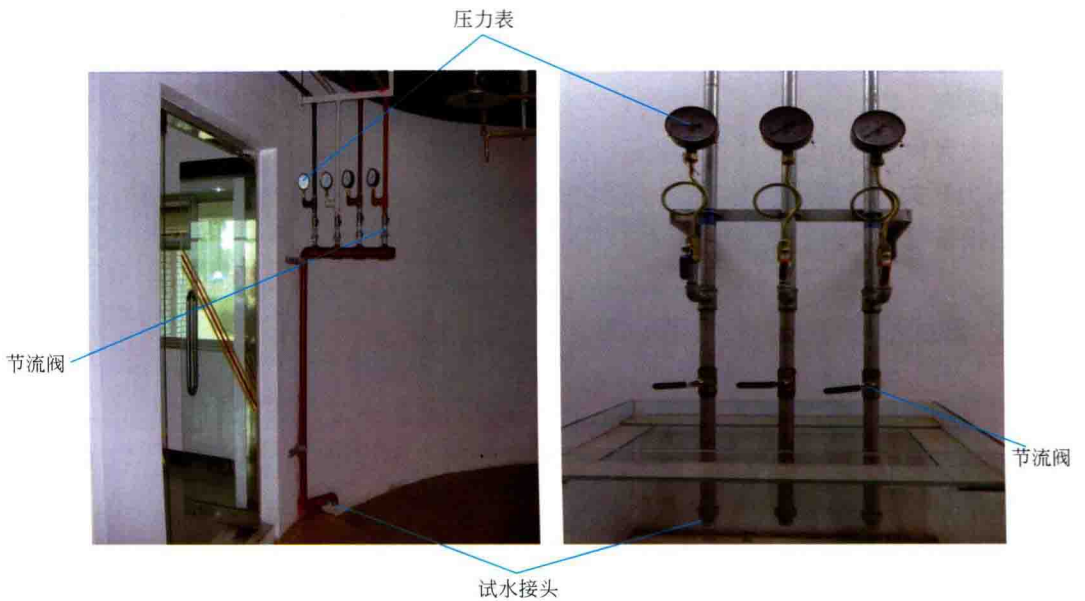
图 10-23 末端试水装置
