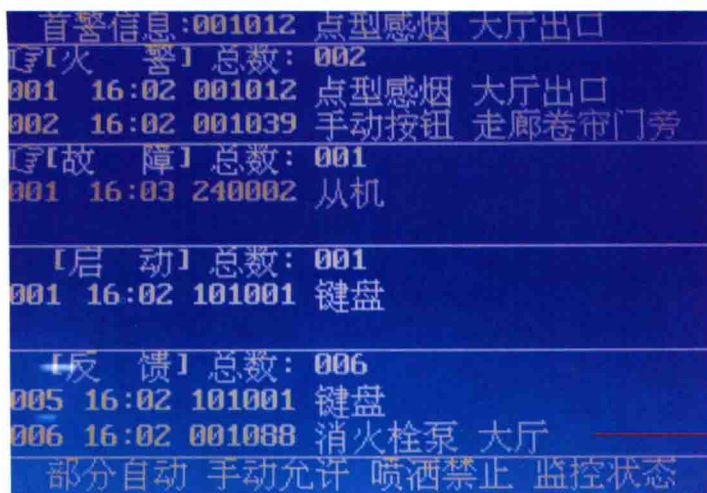
图9-64 液晶显示屏上显示消火栓泵启动
