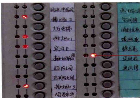
图9-71 消防手动控制盘上显示送风机启动
