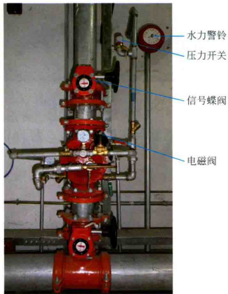
图 10-18 雨淋自动喷水灭火系统
