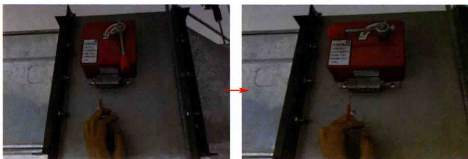
图 10-54 手动关闭防火阀
