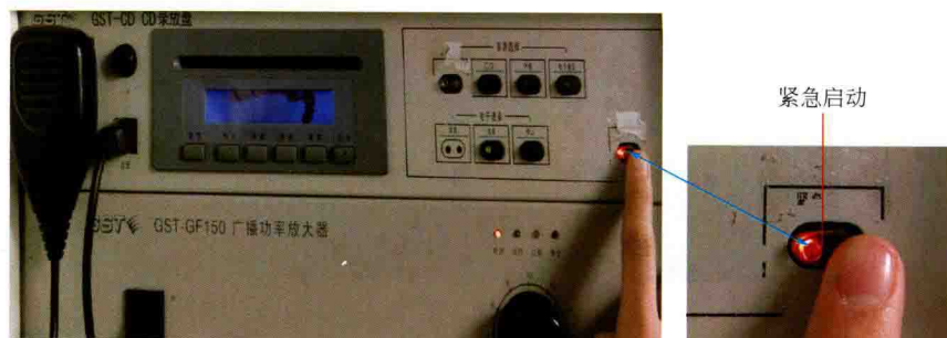
图9-54 再打开“紧急启动”按钮
