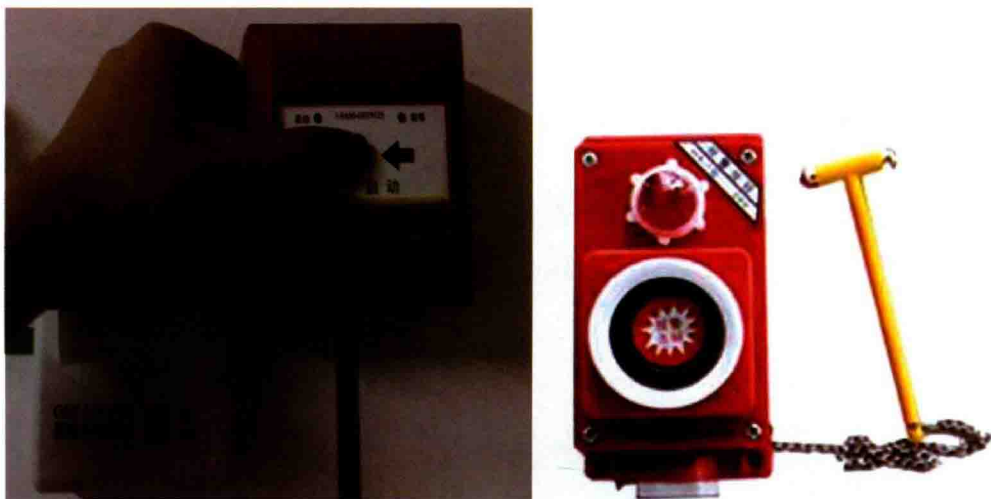
图 10-9 启动消火栓按钮
