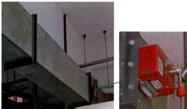
图 10-51 正压送风系统防火阀
