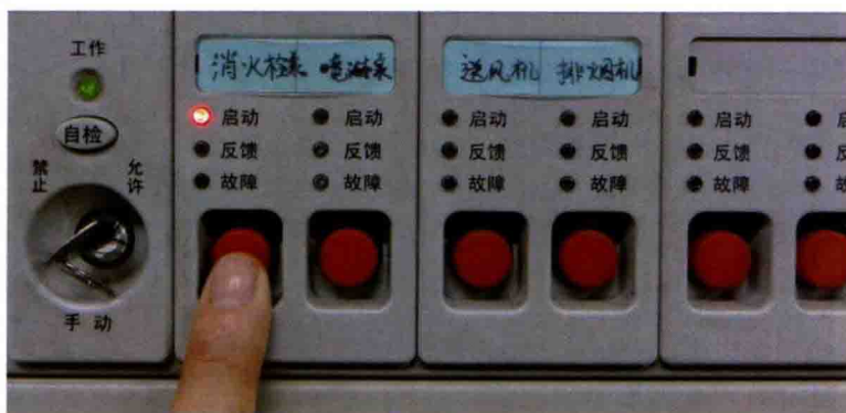
图9-62 多线制控制盘启动消火栓泵
