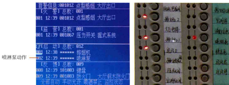
图10-27 喷淋水泵启动的反馈信号
