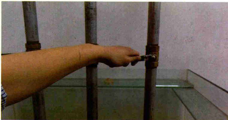
图10-28 关闭末端试水阀门
