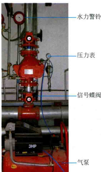
图 10-19 干式自动喷水灭火系统
