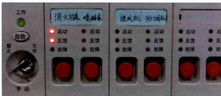
图9-63 消火栓泵启动反馈信号
