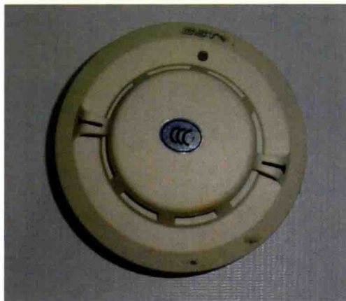
图9-78 烟温复合探测器
