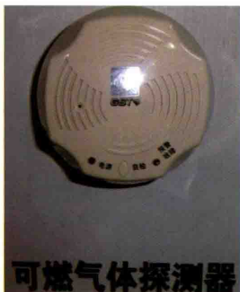
图 9-93 可燃气体探测器和可燃气体报警控制器
