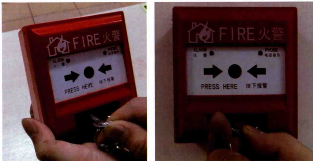
图 10-8 对手动报警按钮进行复位
