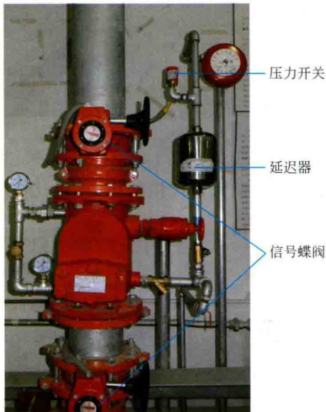
图 10-17 湿式自动喷水灭火系统
