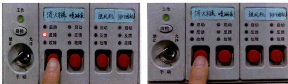
图 9-66 停止消防水泵
