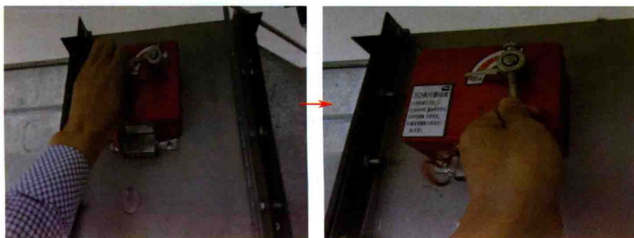
图 10-55 手动复位防火阀
