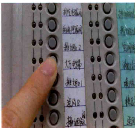
图 10-60 按下多线制控制盘上的电梯按钮
