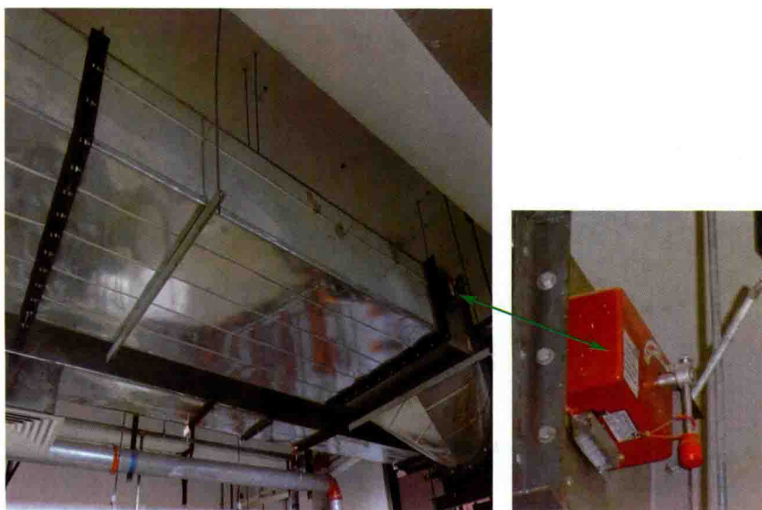
图10-49 机械排烟系统排烟防火阀
