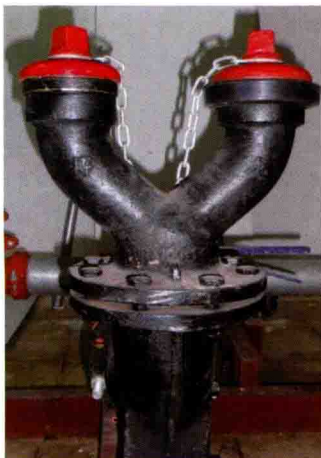
(b) 地下式水泵接合器
