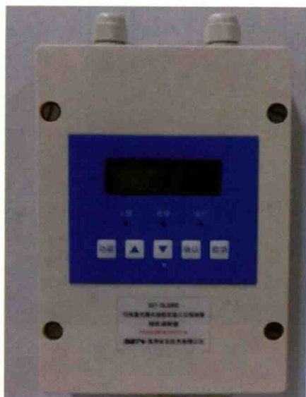
图 9-89 可恢复式缆式线性定温火灾探测器
