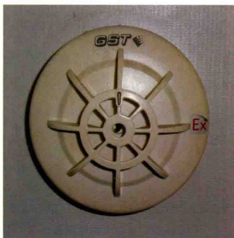
图9-84 感温探测器（本安型）
