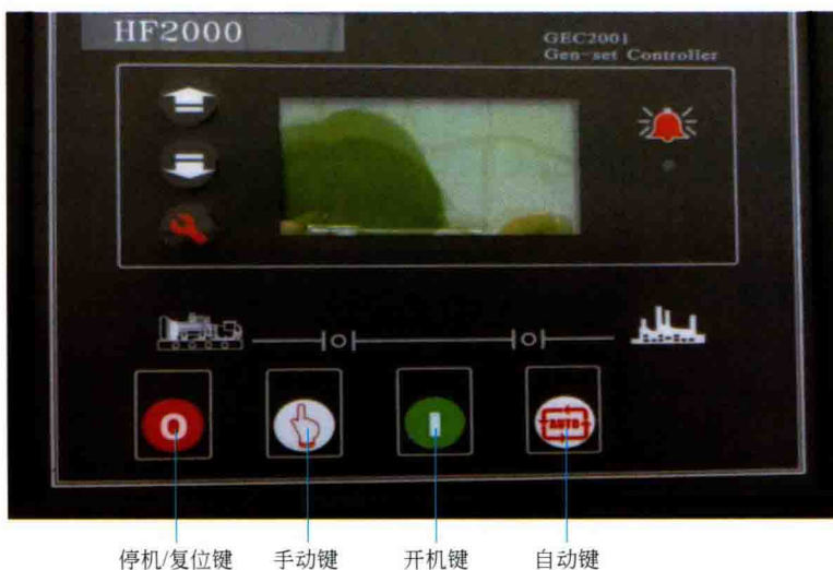
图 10-69 发电机开关按钮
