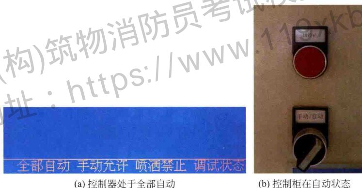
图4-17 控制器和控制柜处于自动状态
