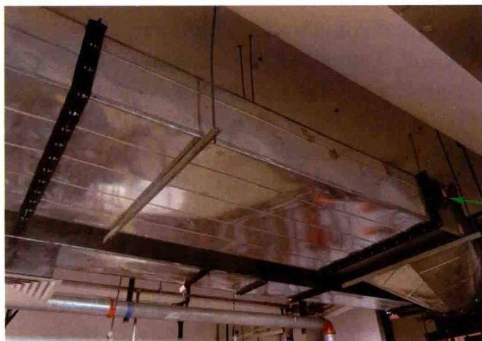
图4-2 机械排烟系统排烟防火阀
