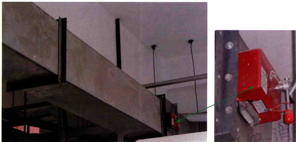
图4-4 正压送风系统防火阀
