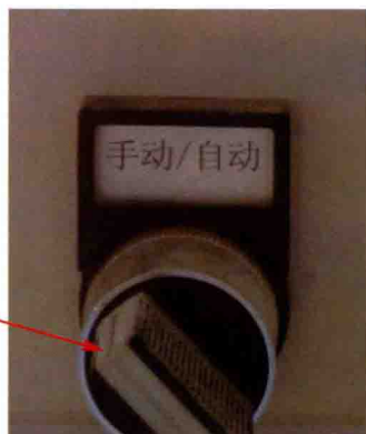
图4-10 风机控制柜的手动状态
