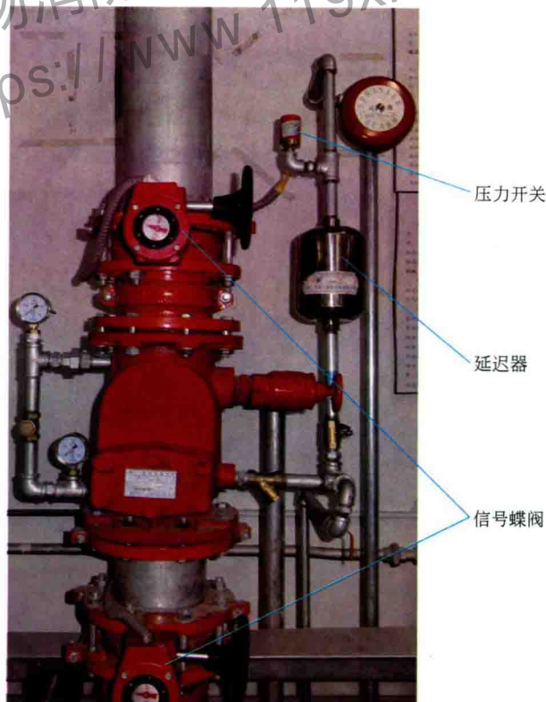
图5-9 湿式自动喷水灭火系统
