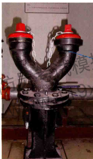
图5-15 水泵接合器
