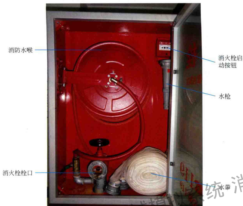
图5-24 室内消火栓各组成部分示意图
