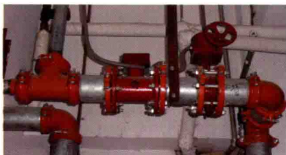
图5-16 法兰式水流指示器
