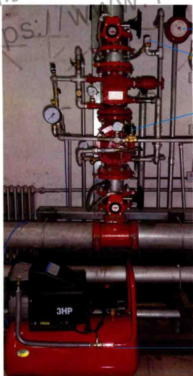
图5-12 预作用自动喷水灭火系统
