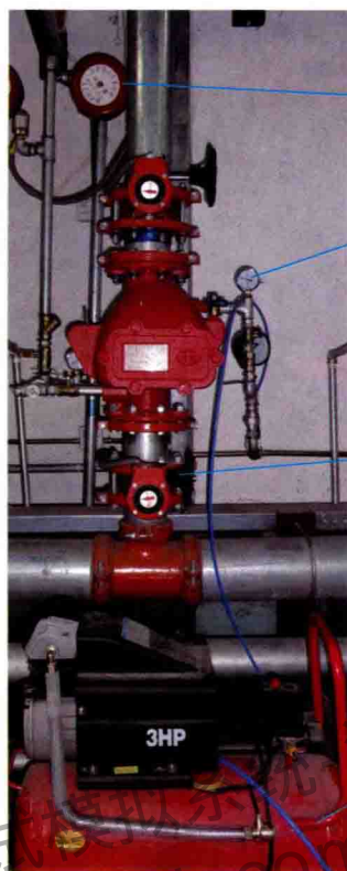
图5-11 干式自动喷水灭火系统
